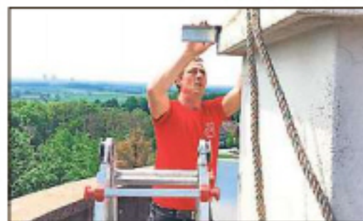
Mit Seilen sichern sich die Handwerker auf der Soestwarte, im Bild Dietmar Brock.
