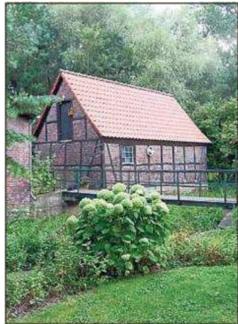
Beckums erste „Tiefgarage“: Hier wurden die Pferde der Bauern untergestellt.
